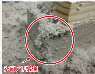
薬剤無塗布の試験体 (蟻道の形成あり)
