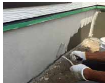
トップコート (ウールローラーで施工)
