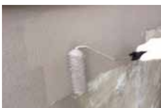
203タイプ (ウールローラーで施工)
