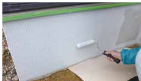
ラビットシューズ (砂骨ローラーで施工)
