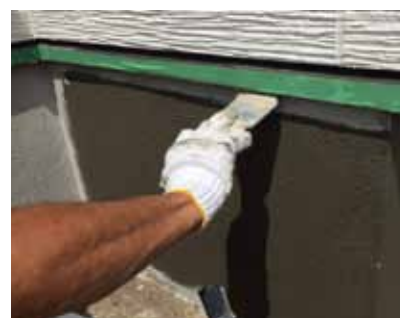
トップコート (ハケで施工)
