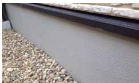
202タイプ(砂骨ローラーで施工)
