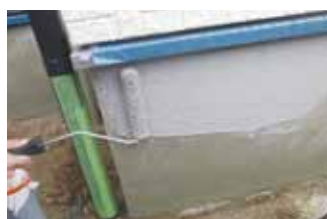
CTバリアー (砂骨ローラーで施工)
