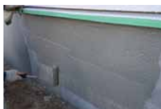
102・202タイプ (砂骨ローラーで施工)
